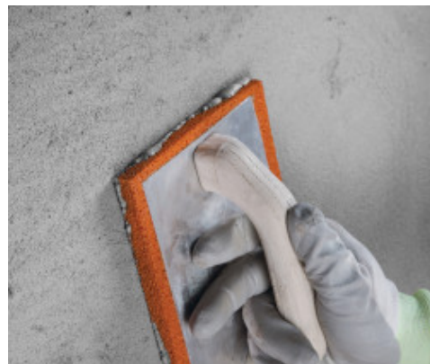
Úprava povrchu Planitop Rasa & Ripara Zero houbovým hladítkem
