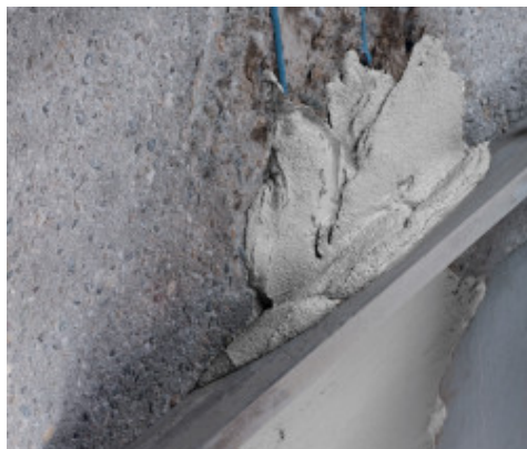
Stahování směsi Planitop Rasa & Ripara Zero hliníkovou latí
