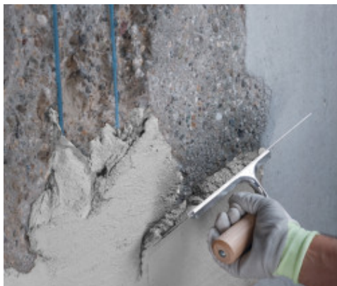
Nanášení směsi Planitop Rasa & Ripara Zero stěrkou
