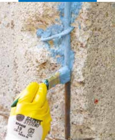
Ošetření ocelové výztuže výrobkem Mapefer 1K
