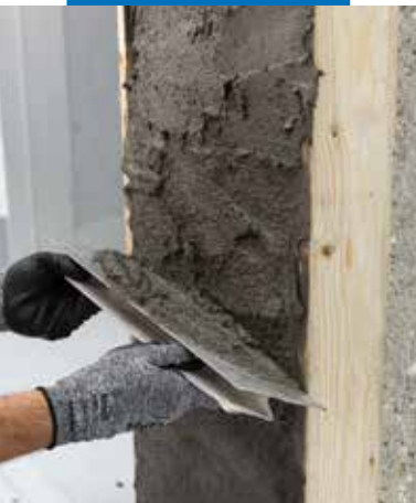
Vyhlazení Mapegroutu Easy Repair
