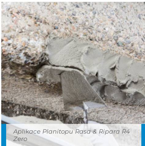
Úprava povrchu Planitopu Rasa & Ripara R4 Zero
